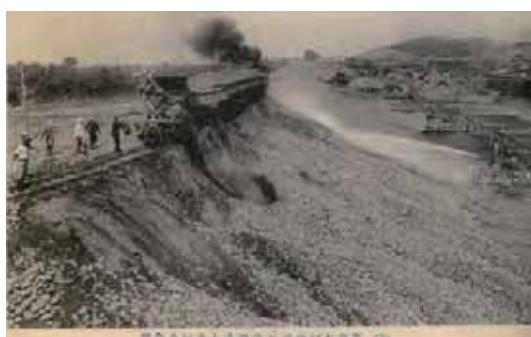
圖二十三 嘉南大圳堰堤下流側盛土及射水作業
