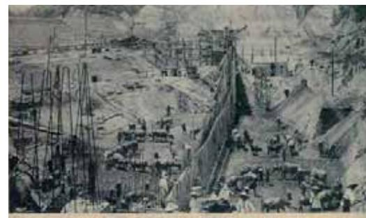
圖二十六 嘉南大圳堰堤中心水泥灌漿作業
