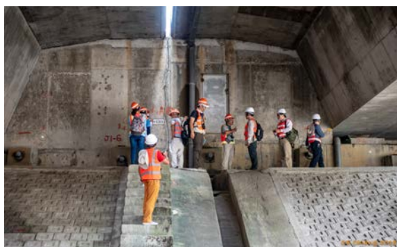
圖一 田寮3號橋北側討論橋梁結構物現況 (江政恩攝)
