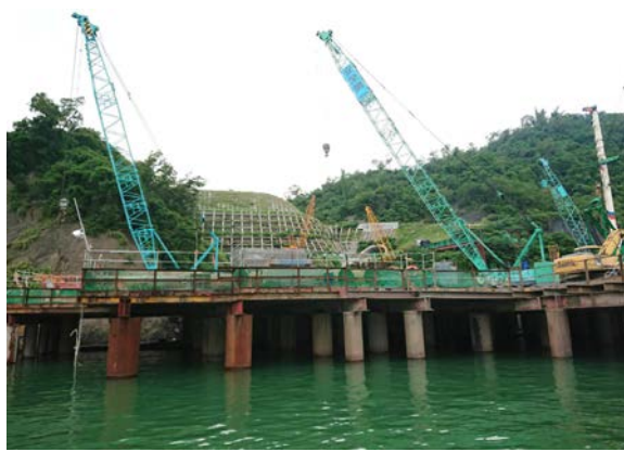
圖八 搭乘船舶至進水口圍堰工區 (朱晃葵攝)
