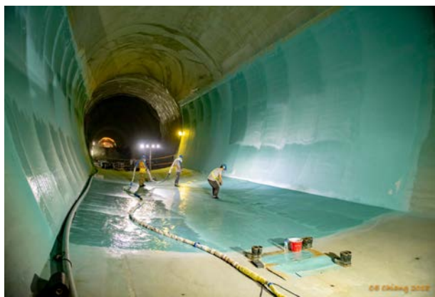
圖七 隧道壁面抗磨材料施工 (江政恩攝)
