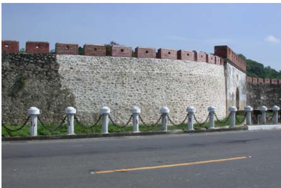
圖十二 完工後照片
