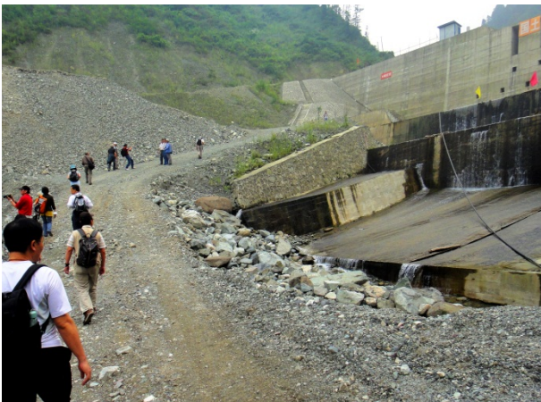
紅椿溝整治工程大型攔土石壩考察(高秋振攝)
