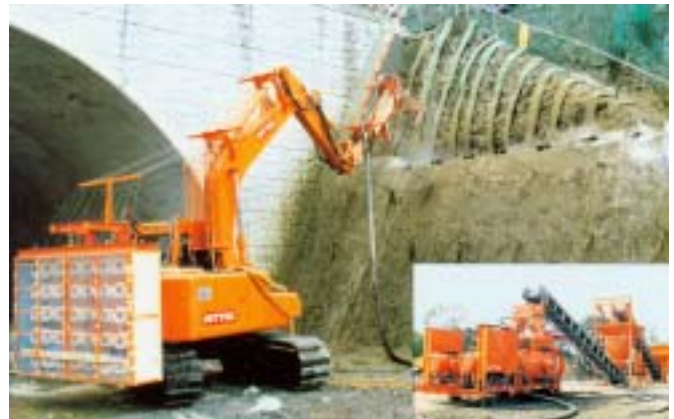
圖二 GEOFIBER工法之施工設備
