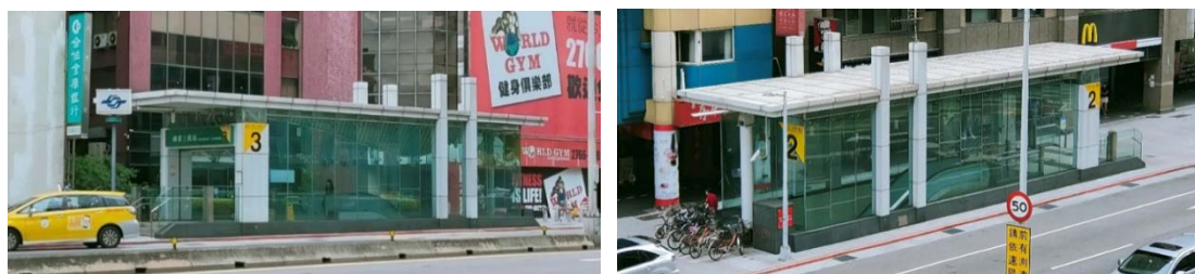
圖十 南京三民站出入口 B、C 完工後現況
