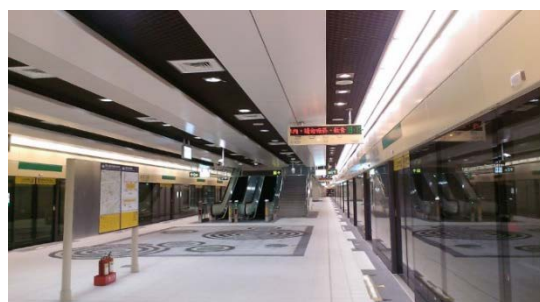
圖十二 南京三民站月台層完工後現況
