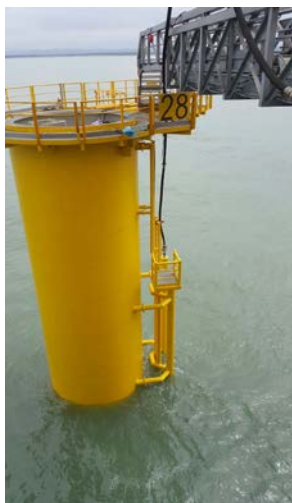
C10 單樁與轉接段接合灌漿 接合採BASF MF9500高強度灌漿材料，單壓強度可達120MPa
