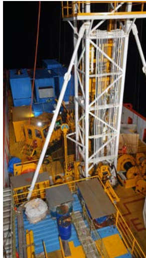
C8 GE鑽探施工
