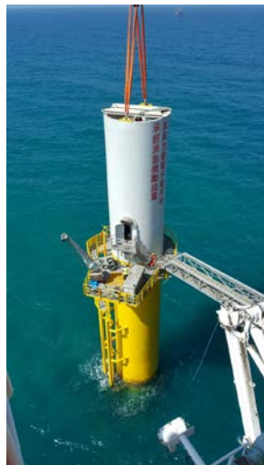
C11 塔筒吊裝與轉接段接合 風機塔桶係分三段在海上組裝 桶身直徑約5公尺，採用124支 螺栓接合
