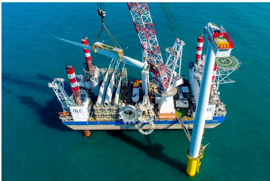
C2 風機葉片吊裝係採用Siemens專用之吊掛組件，可調整葉片姿態，以配合機艙之扇葉法蘭螺栓接合
