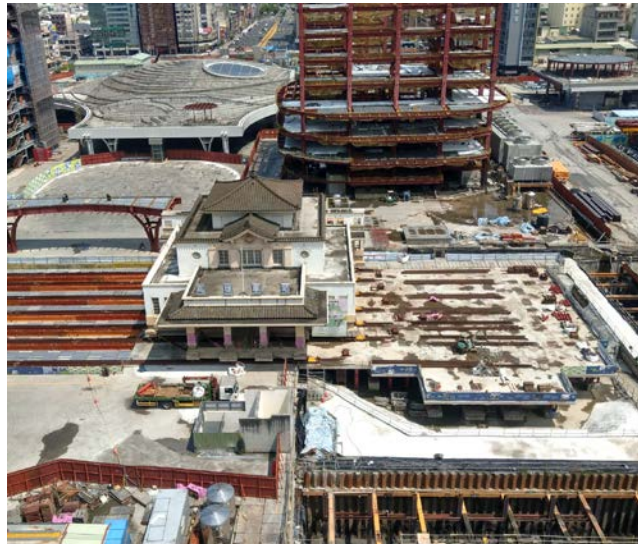
C3 高雄舊車站2021年第二次遷移過程
