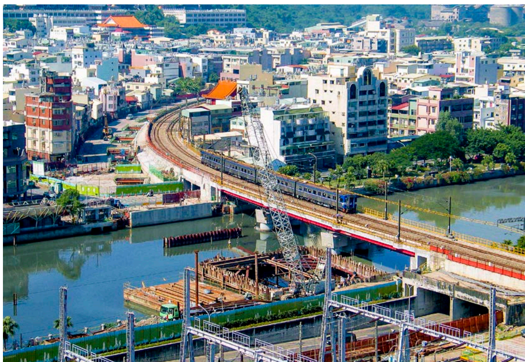
C5 跨愛河段臨時軌道橋及河中圍堰
