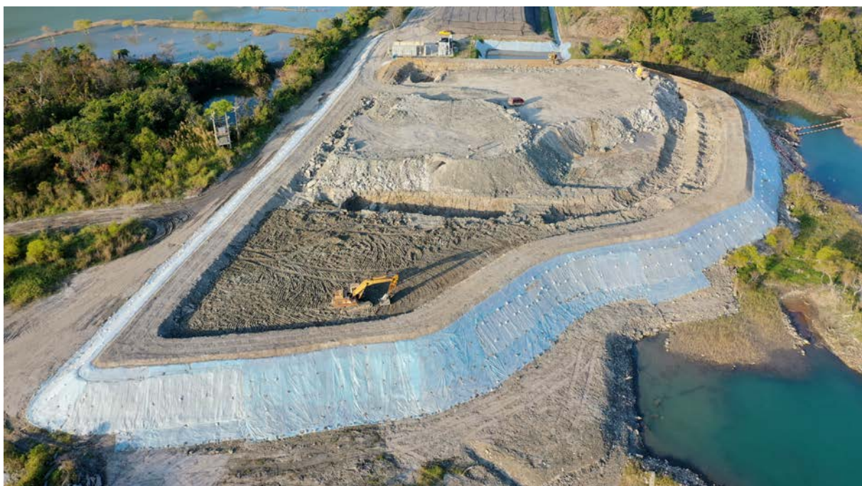
C3 隧道開挖碴料土方堆置考量滯洪沉砂需求，施工中降低開發對環境沖擊，施工中暫置水庫庫區內，隧道貫通後利用隧道做為清運通道去化
