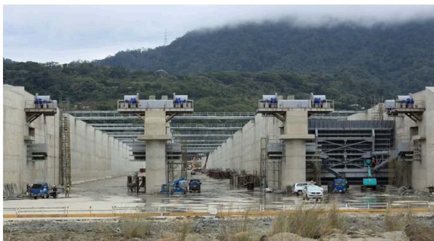
B2 沖淤池為三槽(寬 20 公尺)明渠，末端弧形閘門寬 18 公尺，為全國最寬的規模
