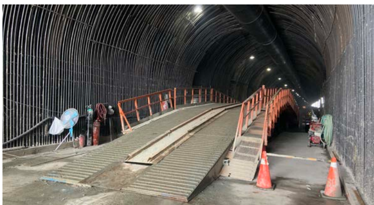
C4 阿姆坪隧道採用國外長隧道常見的仰拱棧橋工法，可增開工作面同步進行隧道開挖出碴，隧道仰拱及側壁襯砌結構施工
