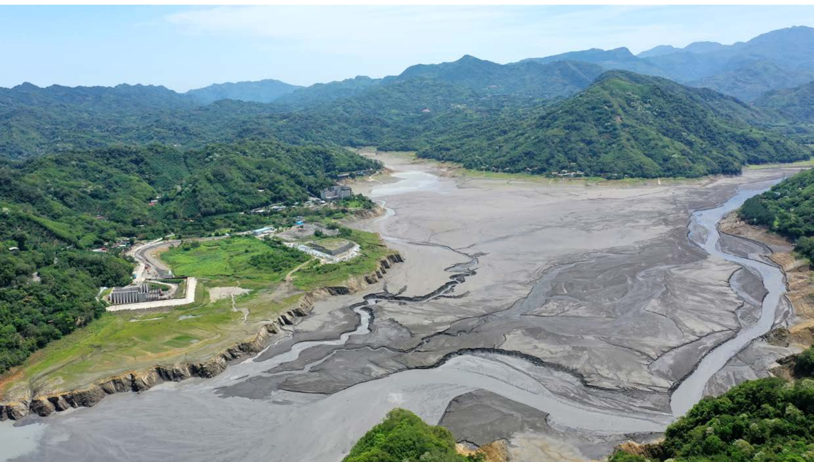
A1 石門水庫的淤積物造成約三分之一的庫容損失，為了從容面對極端氣候下可能的枯旱期，水庫清淤一直是重大的挑戰課題，照片現況為進水口附近，水庫中上游淤積三角洲樣貌
