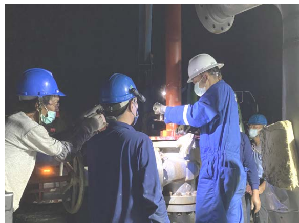
圖五 原廠技師進行安裝作業
