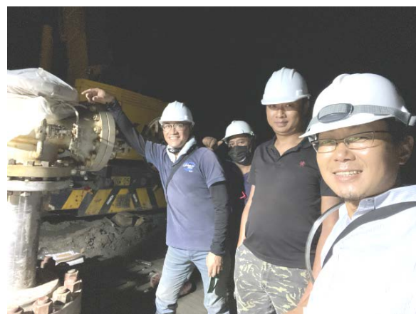
圖六 井下泵浦安裝完工
