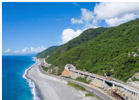
圖九 多良改線段切換通車情形
