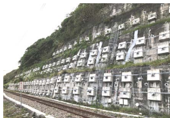
圖十三 富山邊坡補強後情形
