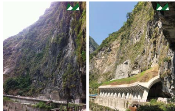
圖五 明隧道施工前及完工全景(2012及2018，青山工程，高振誠攝)
