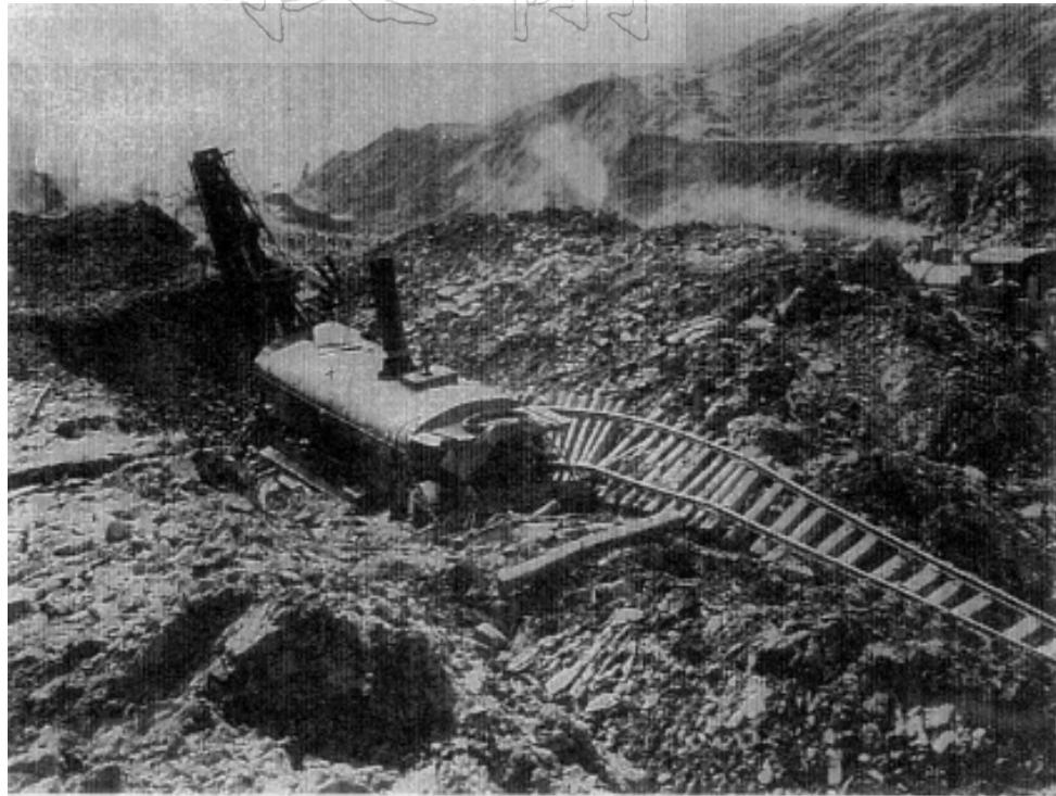
照片四 Gaillard Cut發生於1913年2月6日的Powderhouse滑動，照片中央可見蒸氣
