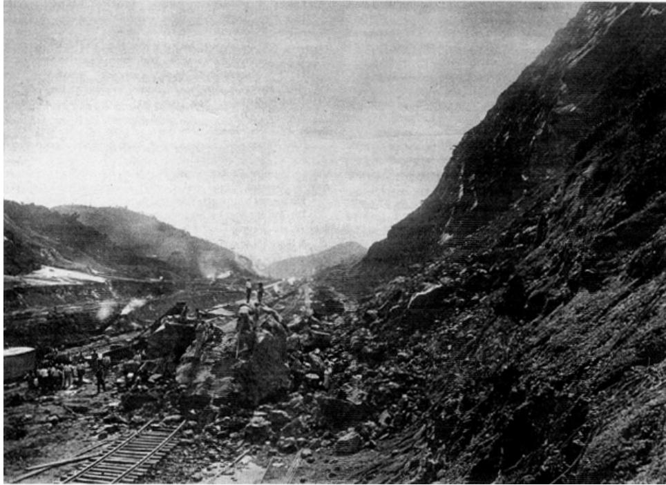
照片五 1910年11月14日發生於Contractors Hill 因切坡而造成的順向坡岩塊滑動
