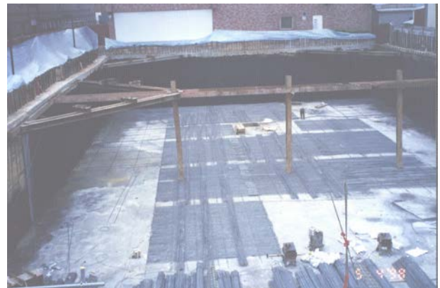
照片一 桃園觀音案例開挖完成
