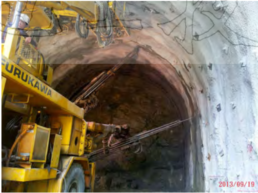
圖十一 東岳隧道北洞口中央導坑岩栓鑽設
