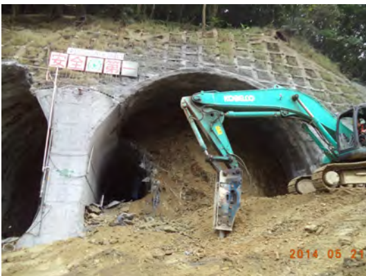
圖十四 東岳隧道北洞口南下線開挖
