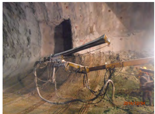
圖十六 南下線仰拱噴凝土
