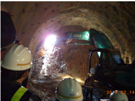
圖十二 東岳隧道北口中央導坑(S164環)開挖貫通
