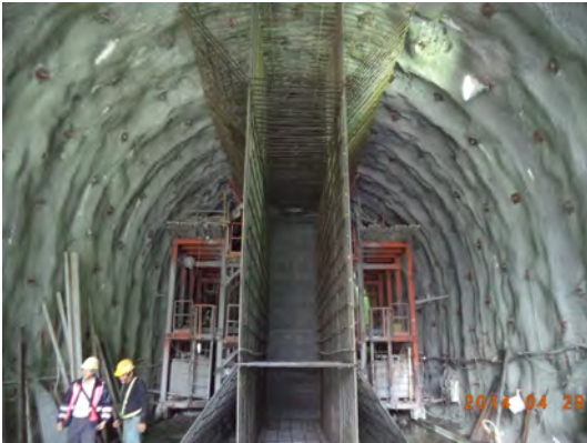
圖十三 東岳隧道中央導坑中間牆鋼筋組立
