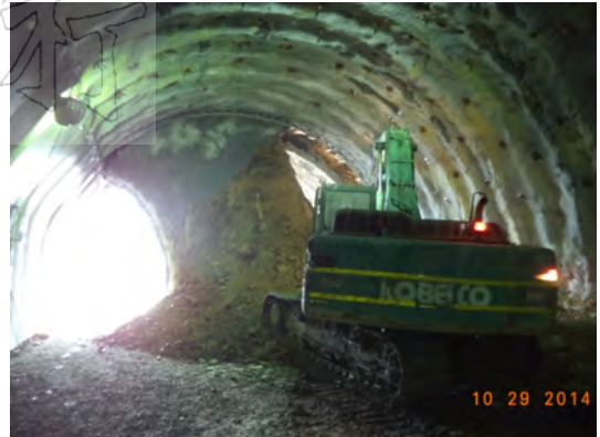
圖十五 東岳隧道南下線SS-T172開挖貫通
