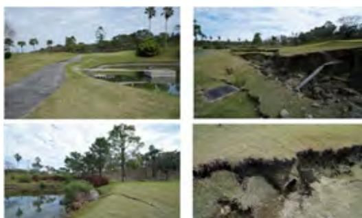
圖十 南寶高爾夫球場現場邊坡破壞照片
