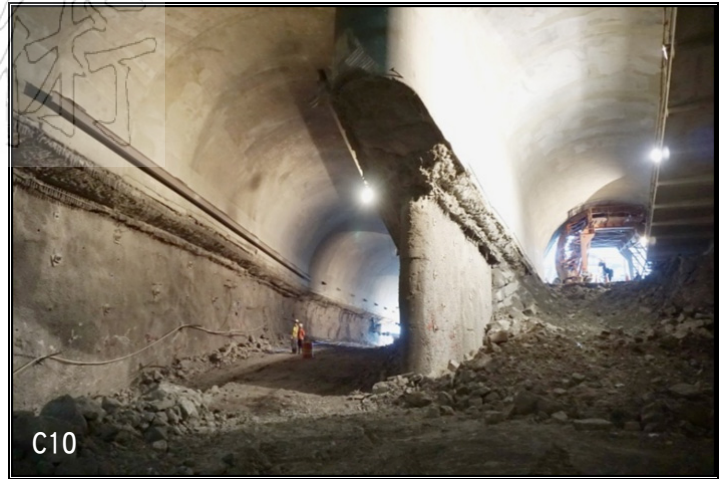
C09、C10 防淤隧道出水口為雙孔洞室，C09 為出水口隧道完成頂部開挖情況，C10 為雙洞隧道完成頂部開挖及襯砌後，降挖支撐及中間岩柱照片
