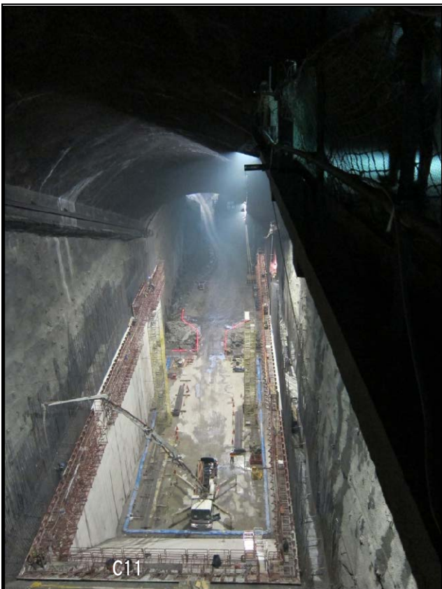
C11 放淤之高流速水流需排放至曾文溪河道，因河道狹小，需透過山體內地下洞室作為消能池，消能池最大淨高 41.7 公尺，淨寬 18.0 公尺，池底長 90.0 公尺，照片為完成開挖支撐後側牆混凝土由下向上澆製情況
