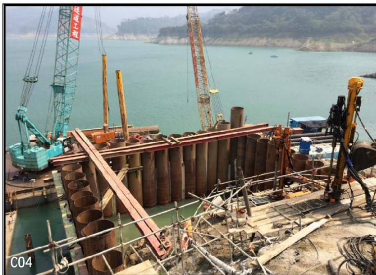
C04 進水口在水庫正常運作下進行擋水圍堰施工狀況
