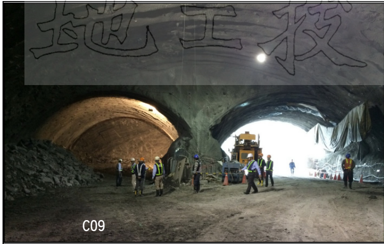
C09、C10 防淤隧道出水口為雙孔洞室，C09 為出水口隧道完成頂部開挖情況，C10 為雙洞隧道完成頂部開挖及襯砌後，降挖支撐及中間岩柱照片
