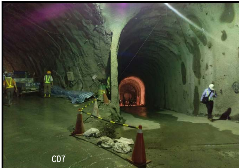
C07 高速水流可能造成水舌不穩產生負壓、穴蝕狀況，為提供氣流於放淤過程順暢對流之路徑，照片中於施工橫坑擴挖交叉段作為通氣隧道，右側為 3 公尺直徑圓形通氣隧道，將有助於消能池水流流態
