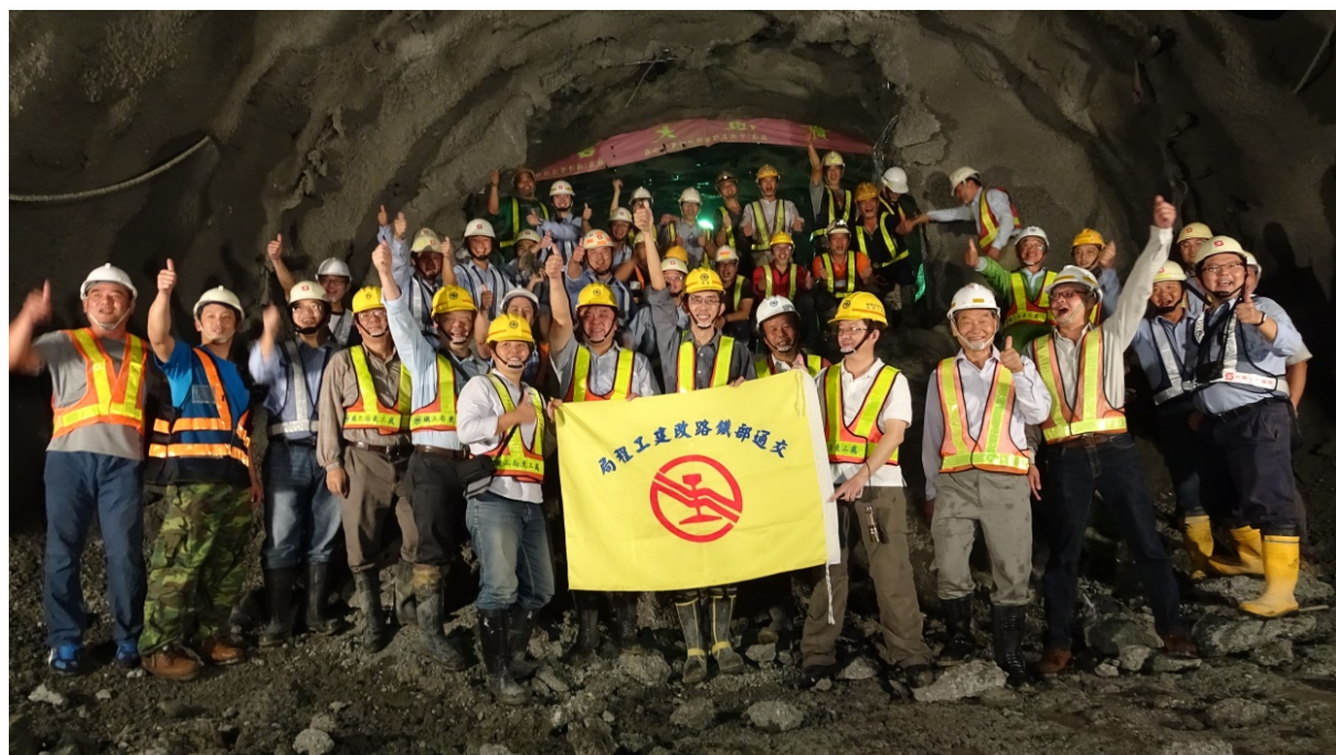
圖十七 新自強隧道中導坑貫通
