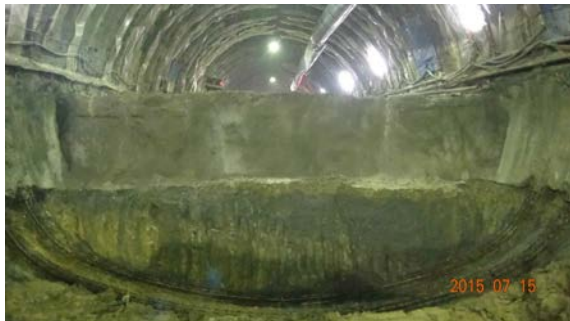
圖十二 新自強隧道短台階開挖及仰拱閉合
