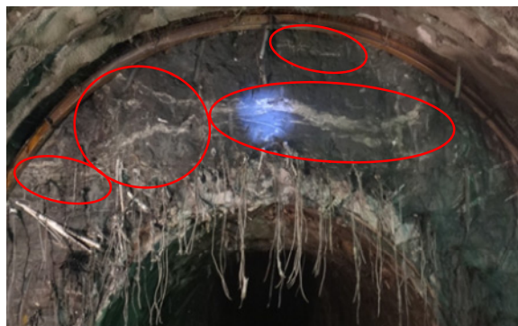
圖十六 中導坑進行複合式漿材灌注成效
