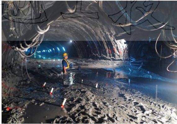
圖十 新自強隧道下半部固結灌漿
