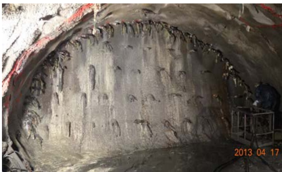
圖九 新自強隧道開挖面預加固工法
