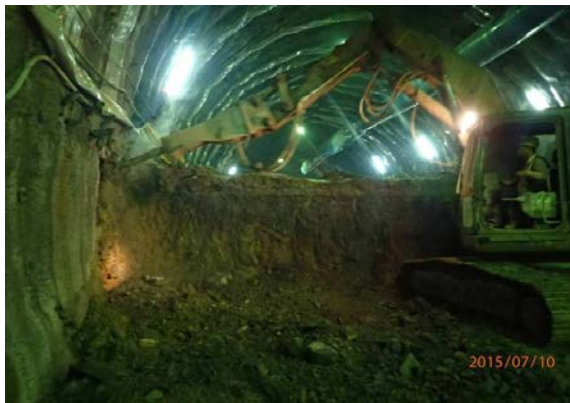
圖十一 新自強隧道短台階開挖
