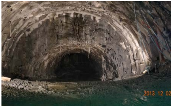
圖七 新自強隧道沉泥層中導坑工法
