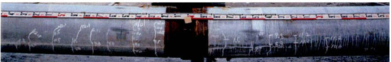
照片四 \Phi 400\text{mm} 高韌性樁試驗結束後之龜裂狀況
