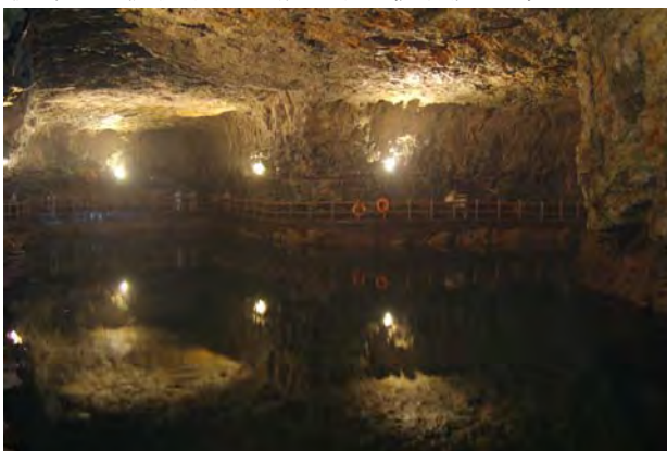
圖九 南竿島北海坑道，水道寬10m，高18m，全長640m，漲潮水位8m，退潮水位4m，可供百餘艘登陸小艇使用
