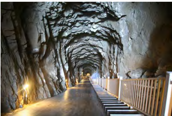
圖十一 東引島安東坑道入口坡道以30°下降約250m(左)，坑道內可容納整個連隊於地下生活及進行軍事防禦(右)(左圖朱育正先生攝)
