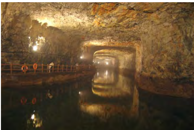
圖九 南竿島北海坑道，水道寬10m，高18m，全長640m，漲潮水位8m，退潮水位4m，可供百餘艘登陸小艇使用
