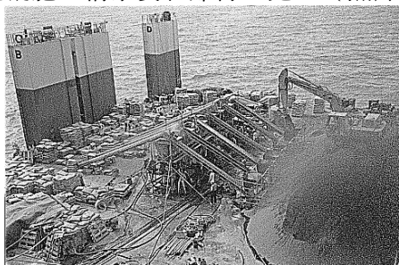
照片十八 高雄興達港卸煤棧橋橋墩海上預疊混凝土 (prepacked concrete) 施工情景 (民國 75 年)
