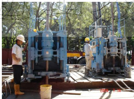
照片十三 台北捷運 570H 標聯通道地盤改良 RJP 工法（民國 92 年）
