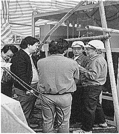
照片十一 SL 藥液自動拌合機現場解說(民國 75 年於台北鐵路地下化工程)
