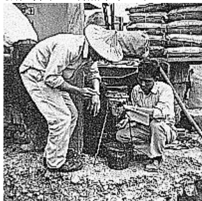
照片十六 高雄建國橋用流量錐測量水泥砂漿稠度（民國 50 年蹲立者為林先生）
