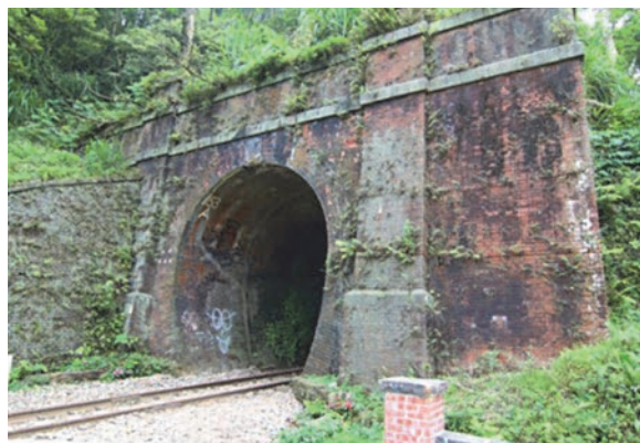
(a) 一號隧道
