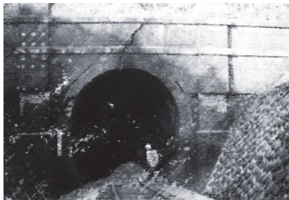
(d) 八號隧道
