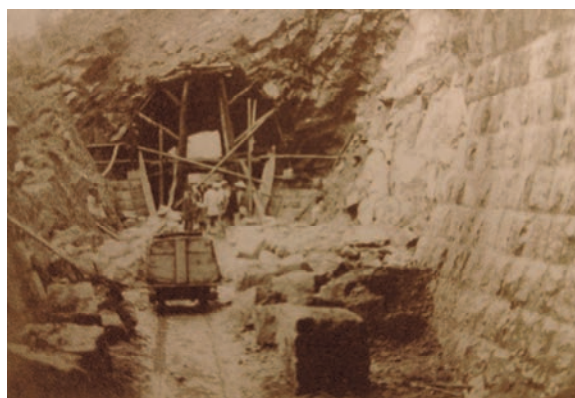
(a) 第二員山隧道
