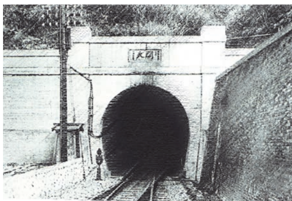
(b) 二號隧道
