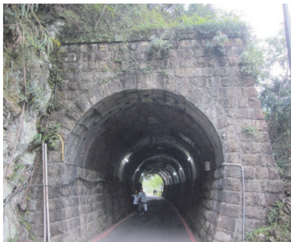
(b) 猴硐隧道
