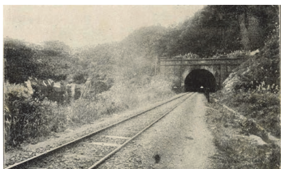
(a) 第一代竹子嶺隧道(舊稱竹子寮隧道)(維基百科)
