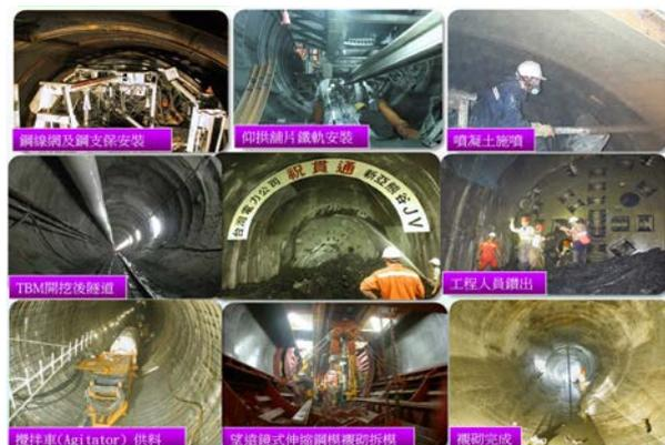
圖二十八 TBM鑽挖支撐襯砌
