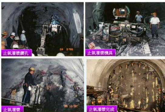
圖十三 止氣灌漿施工
