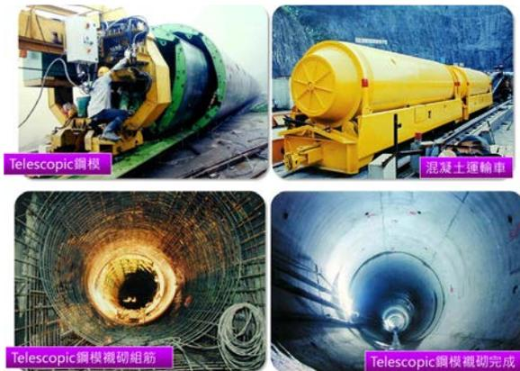
圖二十五 混凝土襯砌
