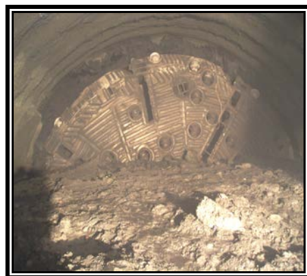
投影片 14 主坑TBM在頂帽坑下開挖
