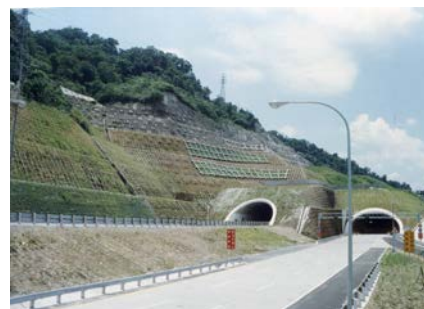
投影片9 新店隧道北洞口邊坡滑動整治
