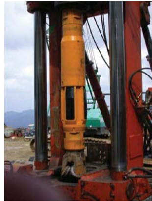
投影片 15 雪山隧道 1 號豎井(500m)以導向鑽孔系統進行昇鑽工法
