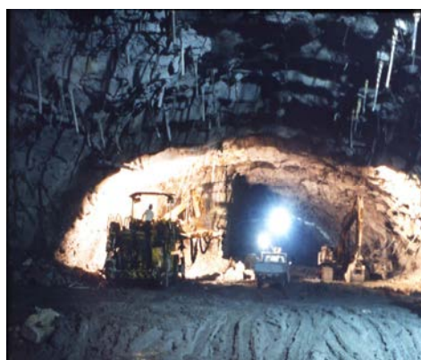
投影片6 廠房頂拱擴挖與預錨
