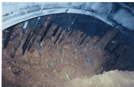
投影片 11 高速公路穿越段卵礫石層開挖採超微粒水泥灌漿與管幕
