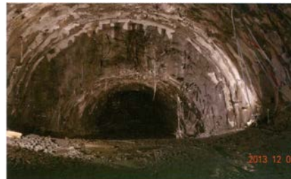
投影片 16 新自強隧道沉泥段先以中導坑貫通再擴挖(摘自地工技術No.151/2017.3)
