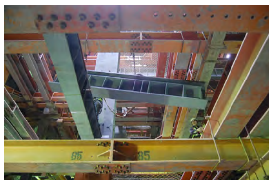
圖十二 地下鋼構吊裝照片
